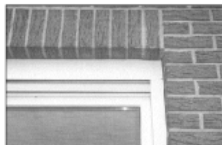
Note 1: Lobung am Fenster einer Klinkerfassade
