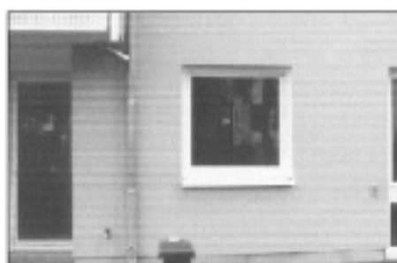
Note 1: Strukturputzfläche an Fassade
