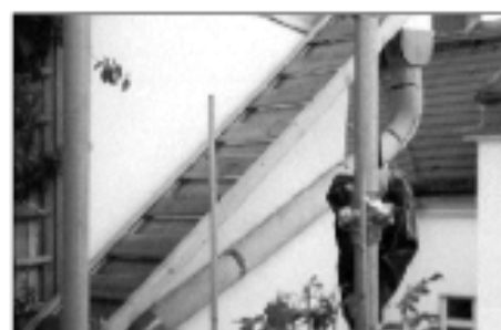
Note 3: Fallrohrverzug ohne zusätzliche Wandhalter
