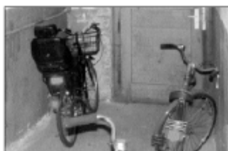
Note 2: Trockene Kellersohle mit geringfügigen Abnutzungserscheinungen
