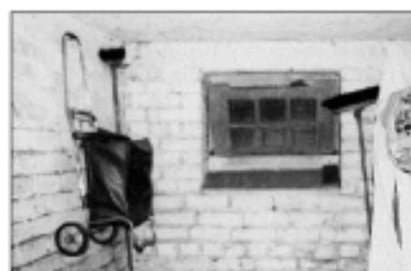
Note 3: Kellerfenster aus Glasbausteinen in funktionsfähigem Zustand
