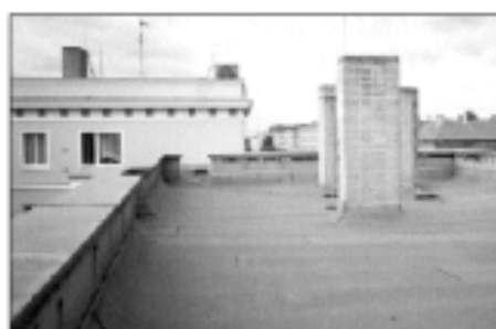
Note 2: Einheitliche Oberfläche der Dachbahnen
