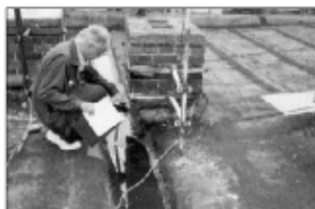
Note 5: Mangelhafter Eindruck mit Pfützen und Flicker
