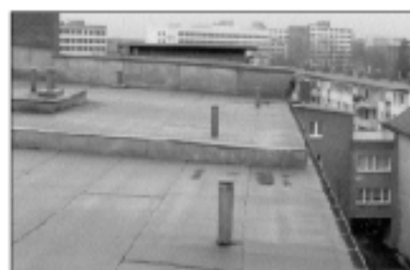
Note 1: Komplett erneuerte Eindeckung, Entlüfter und Regenrinnen
