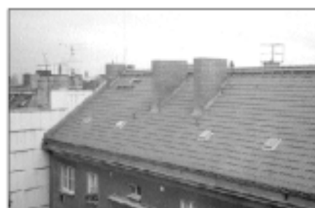
Note 1: Ansicht eines sanierten Daches
